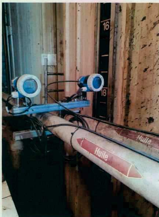
Capteurs volumétriques cuves eau concentrée HC
